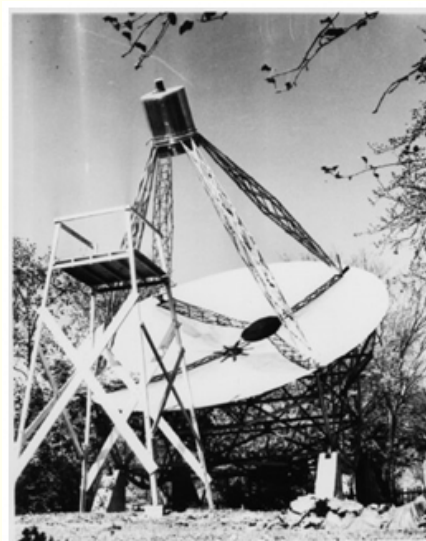
Gambar 2. Antena Reber yang dibangun di halaman rumahnya (kiri) dan replikanya saat ini (kanan). (Sumber: https://greenbankobservatory.org/science/telescopes/reber-telescope/ )
