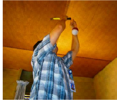
Gambar 3 Pemasangan monitor radon pasip di dalam rumah penduduk.
