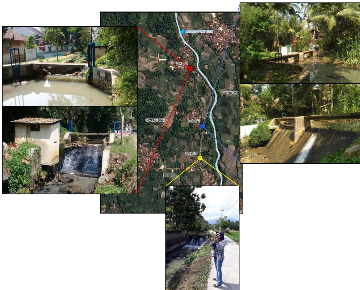
Gambar 5. Bangunan ukur debit ambang lebar.
