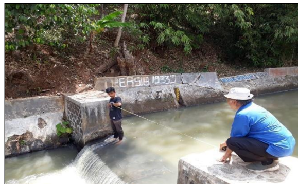
Gambar 5. Bangunan ukur debit ambang lebar.
