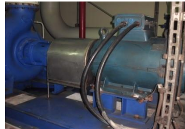
Gambar 5. Motor PA03 AP01 Sistem Pendingin Sekunder RSG-GAS
