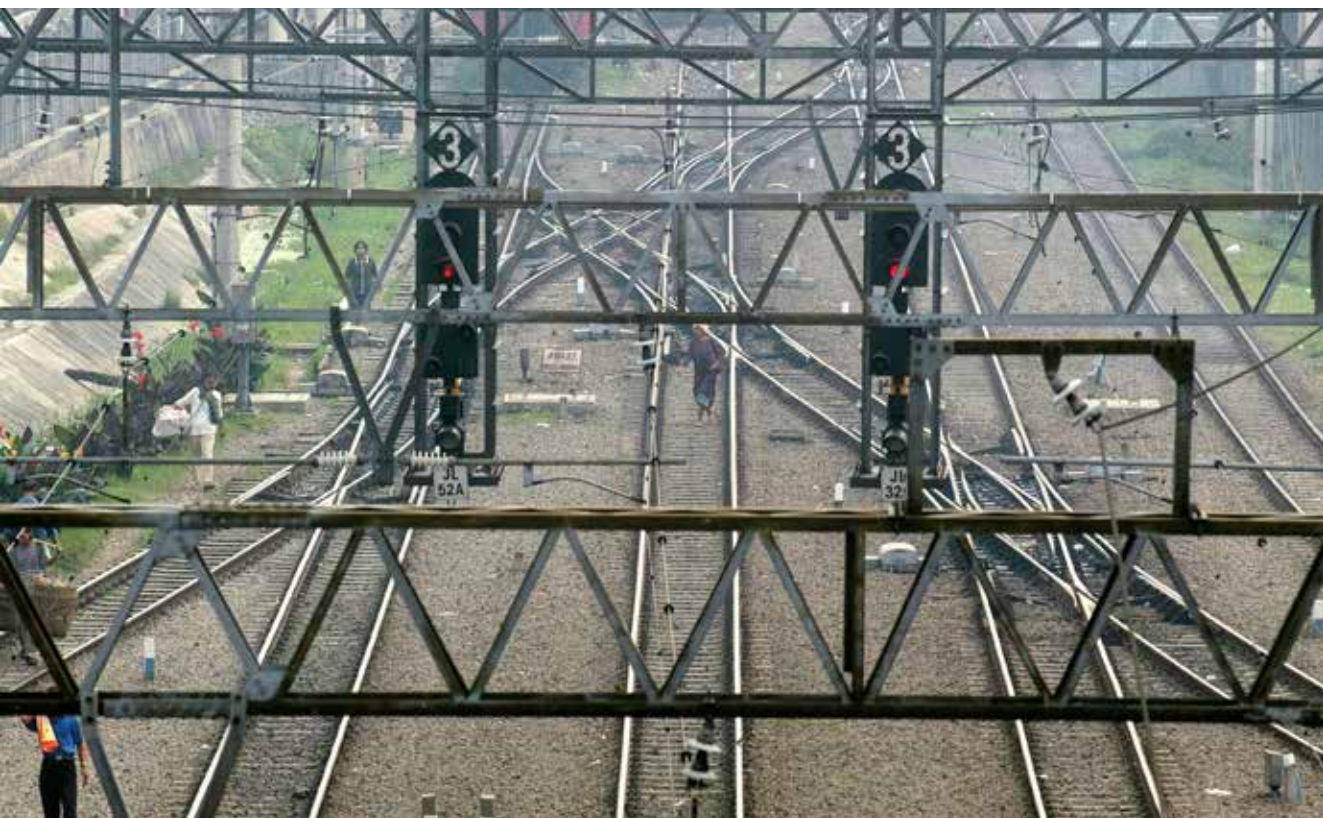
Lampu sinyal kereta api (KA) di Tanah Abang, Jakarta, Jumat, 22 Juli 2005. Pemerintah menandatangani perjanjian investasi dengan perusahaan Sam An dari Korea Selatan sebesar 270 juta US dolar untuk memperbaiki jaringan perkeretaapian di Indonesia yang meliputi perbaikan rel, penambahan gerbong, dan sistem pertiketan. (TEMPO/ Santirta M)
