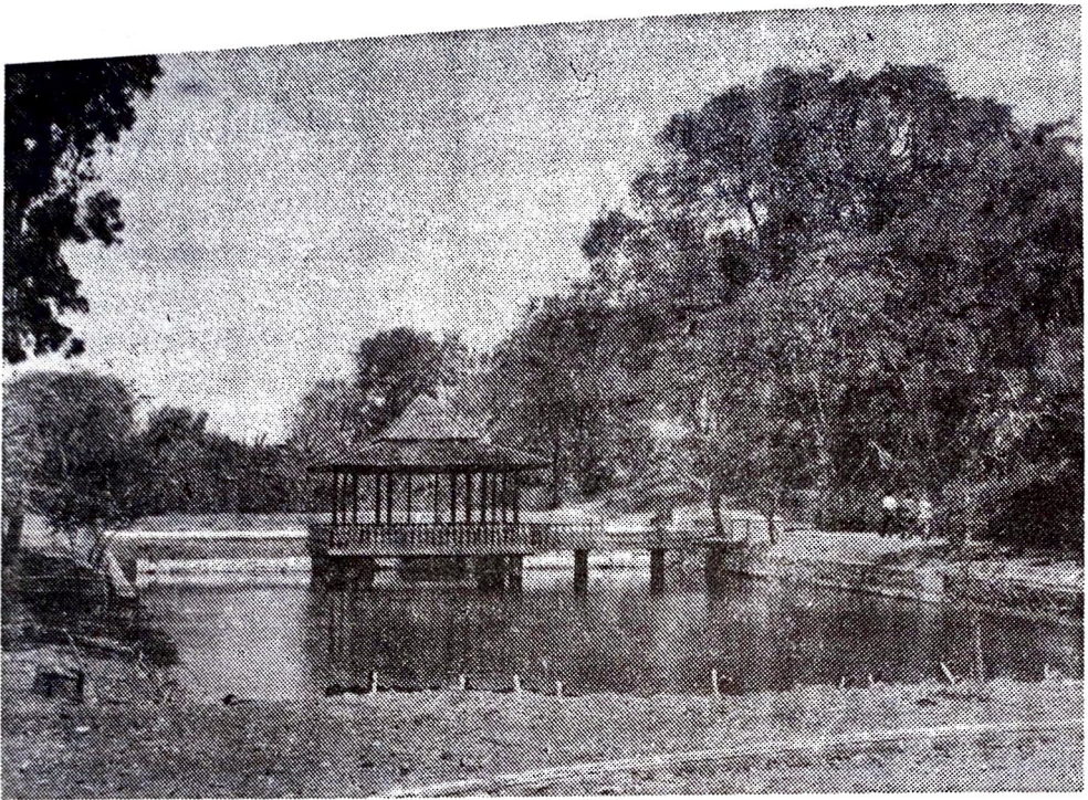
4. Bangunan Bale Kambang 'Mahameru di tengah Samudera' di kompleks Keraton Kasepuhan lama.
