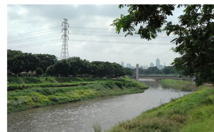
East Flood Canal in Duren Sawit, East Jakarta (Kompas, 2018).
