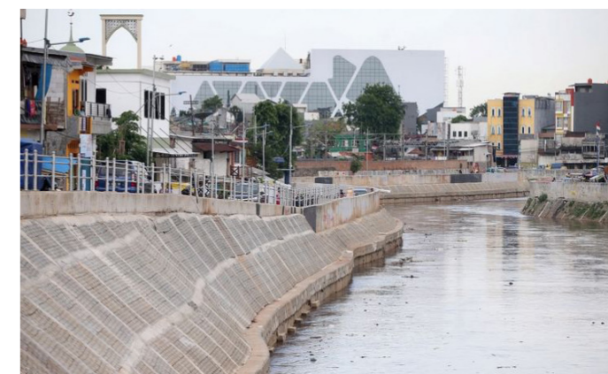
An embankment in Kampung Melayu, Jakarta Timur (Kompas, 2017).
