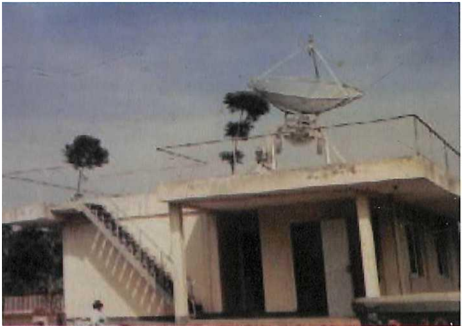
Gambar-15. Antena parabola 606 MHz ditempatkan di atas dak ruang alat pengamatan.
