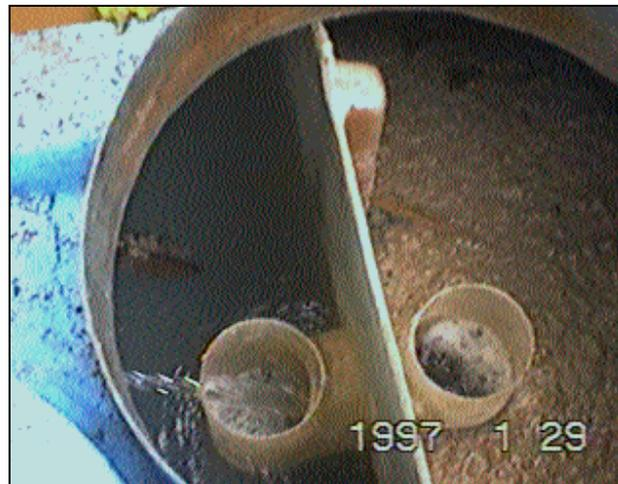
Air limbah di dalam bak pengurai awal (kanan) dan air limbah di dalam bak anaerob I (kiri).
