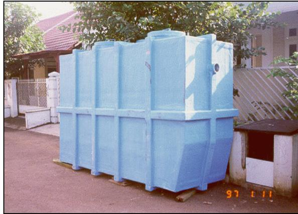
Bentuk reaktor alat pengolah air limbah rumah tangga (dari bahan fiberglas)
