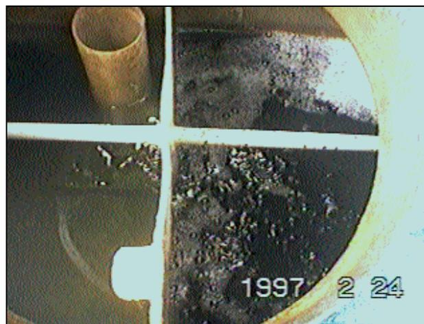
Air limbah di dalam bak anaerob I (kanan) dan bak anaerob II (kiri).
