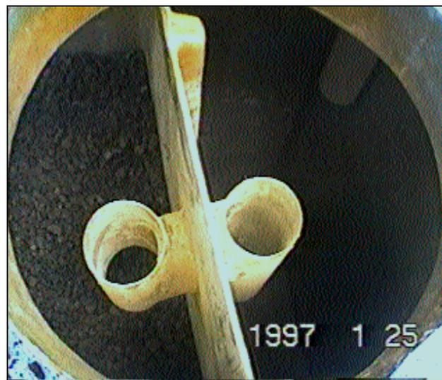
Unit reaktor alat pengolahan air limbah yang telah diisi dengan media batu pecah
