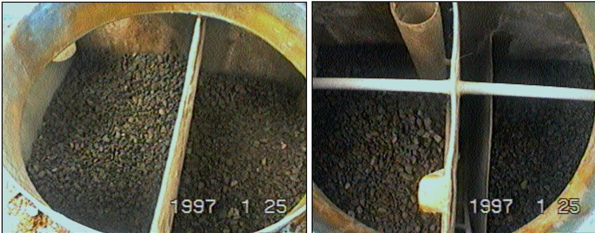
Unit reaktor alat pengolahan air limbah yang telah diisi dengan media batu pecah (split) ukuran 3-5 cm.
