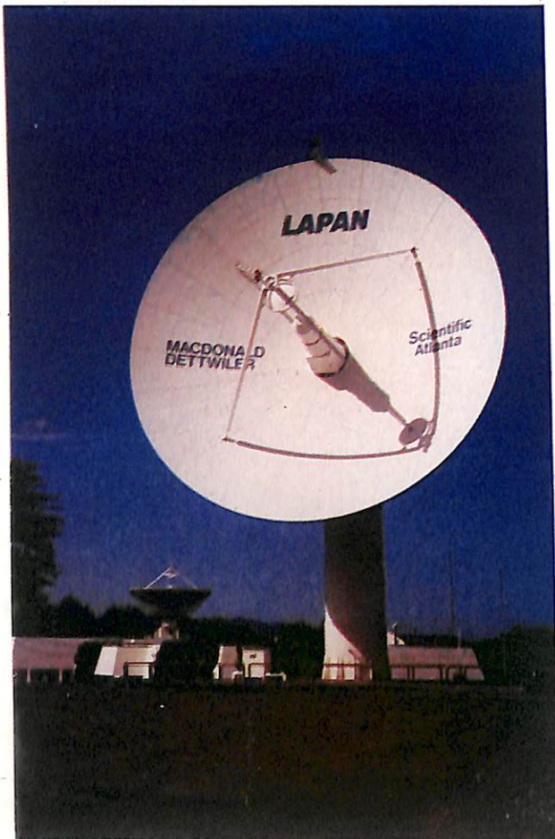
LANDSAT : Di Stasiun Bumi Inderaja Parepare juga terdapat fasilitas penerima data satelit Landsat. Latar depan adalah antena parabola untuk Landsat sementara dilatar belakang adalah antena JERS
