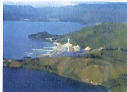
Gambar 6. PLTU Teluk Sirih yang dahulunya adalah lokasi ekosistem mangrove.
