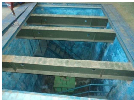
Gambar 4.2. Gelagar memanjang, berada dibawah gelagar melintang
