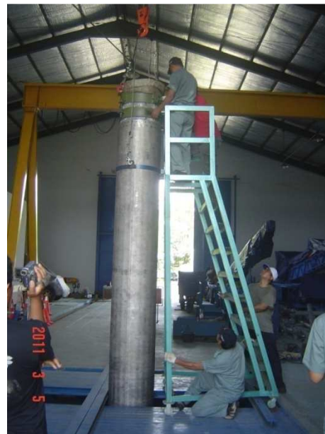
Gambar 1.2. Pembuatan Insulasi Termal
