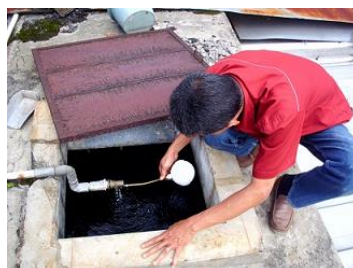
Perbaikan suplai air ke gedung B
