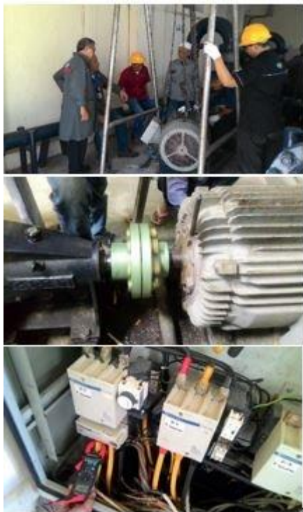
Gambar 29. Kegiatan perbaikan pompa sistem pendingin sekunder
