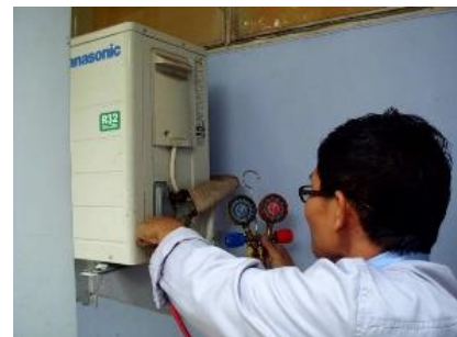
Perbaikan AC Laboratorium Fisika Lingkungan
