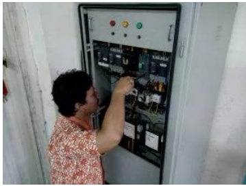
Perbaikan pengaman daya pompa cooling tower
