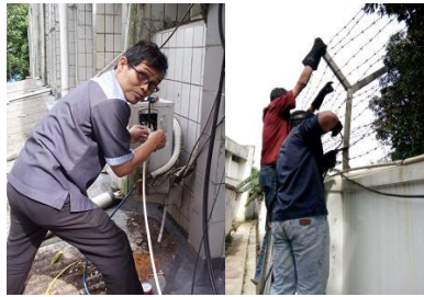
Perbaikan AC server PABX dan tiang apron belakang gedung C
