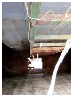
Perbaikan elektroda tower air PSTNT
