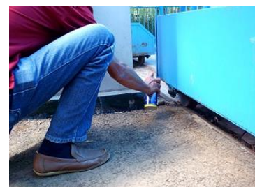
Perawatan pintu gerbang pos jaga
