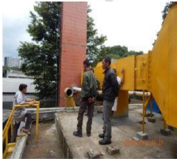
Pengawasan pembongkaran rumah HEPA filter
