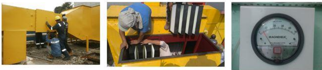
Gambar 26. Kegiatan revitalisasi dan perbaikan sistem ventilasi gedung reaktor
