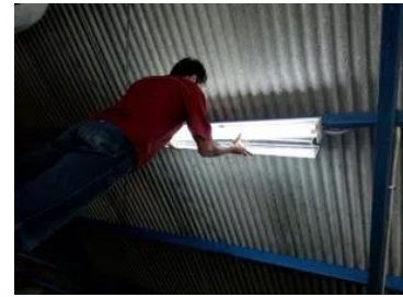
Perbaikan instalasi penerangan di gedung kendaraan
